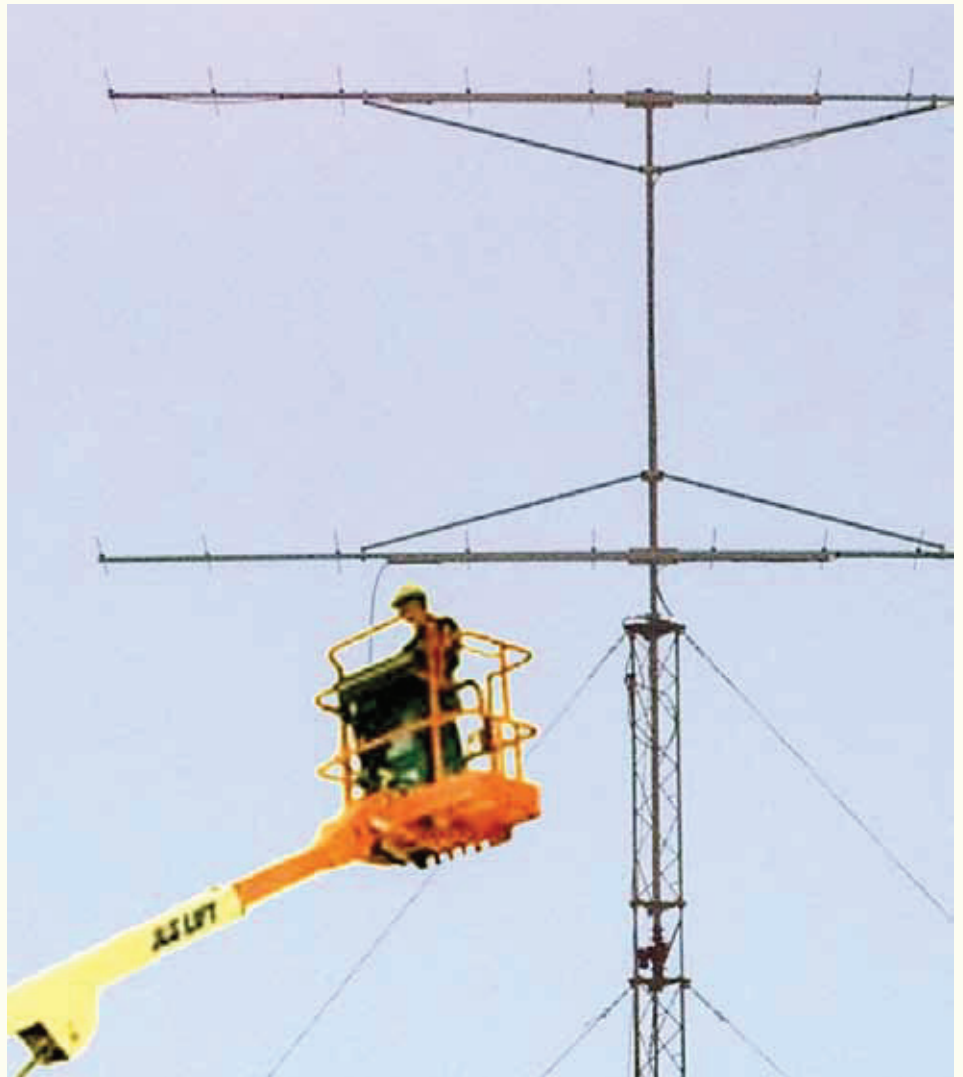
Foto 1 Het tunen van de noise trap aan de antenne in de mast. Deze manier van experimenteren moet je ook niet elke dag doen.
